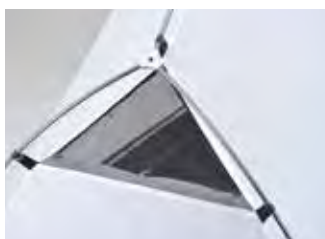
開け閉め可能な通気窓。
